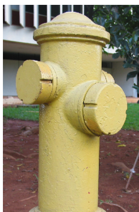
Figura 57 - Hidrante urbano ou de coluna
