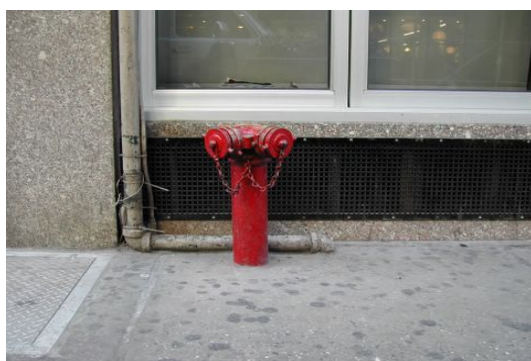
Figura 63 - Hidrante de recalque do sistema de sprinkler
