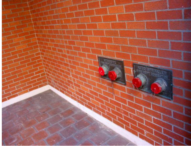
Figura 64 - Exemplo de hidrante de recalque na fachada
