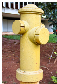
Figura 137 - Hidrante urbano (ou de coluna)
