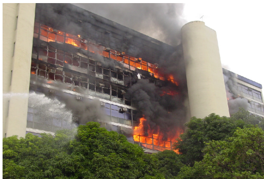
Figura 152 - Incêndio no prédio do INSS, em Brasília-DF – 2005
