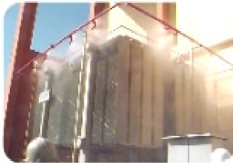
Figura 76 - Exemplo de aplicação do sistema de água nebulizada
