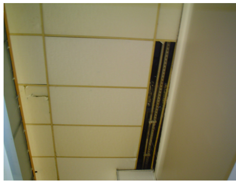
Figura 57 - Exemplo de forro de fibra de madeira
