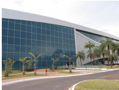
Figura 61 - Prédio com fachada em vidro laminado - Centro de Convenções Ulisses Guimarães
