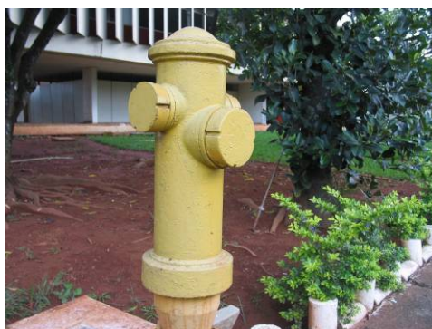
Figura 49 - Hidrante de coluna (ou hidrante urbano)
