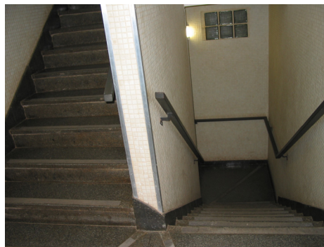
Figura 63 – Exemplo de escada
