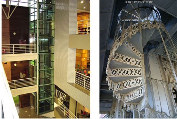
Figura 62 - Fosso de elevador e escada facilitam a movimentação da fumaça na edificação
