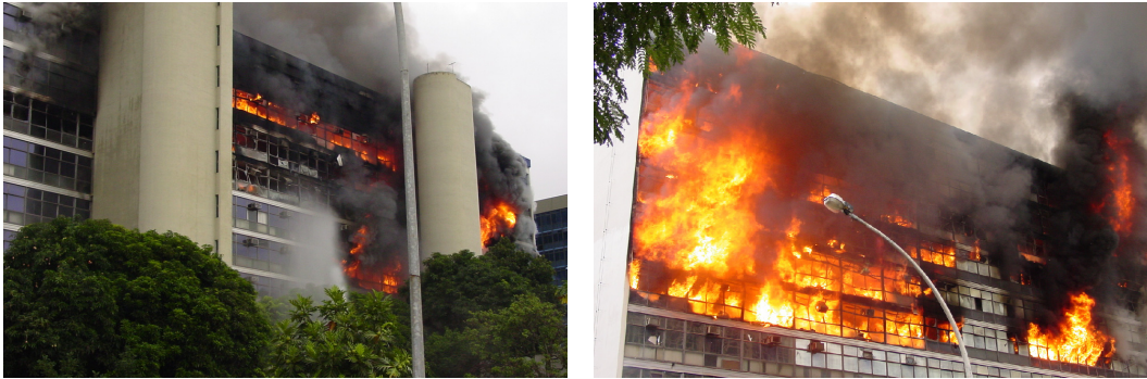
Figura 65 - Incêndio generalizado no prédio do INSS, Brasília-DF, 2005
