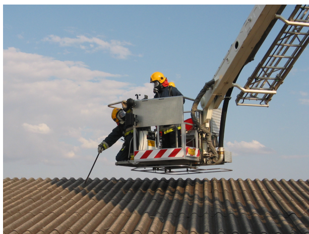
Figura 4 – Acesso ao telhado com a viatura APM
