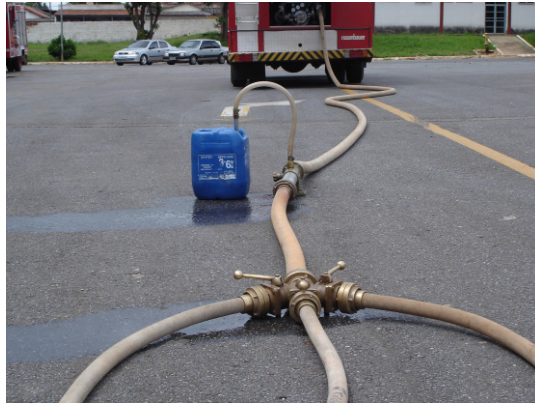
Figura 136 - Bomba armar utilizando espuma nas linhas
