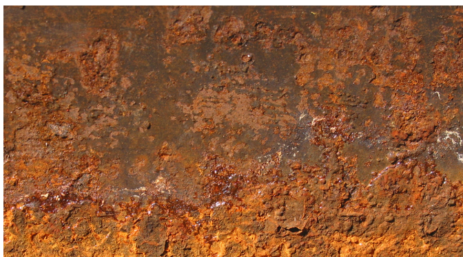
Figura 15 - Material sob ação da ferrugem, que caracteriza uma reação lenta
