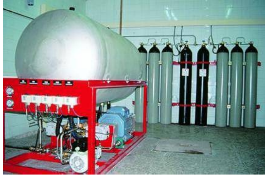
Figura 75 - Compressor do sistema de água nebulizada
