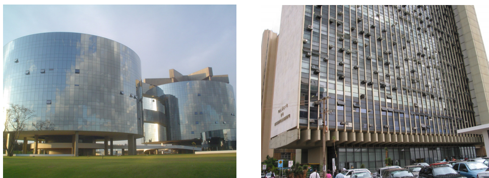
Figura 58 – Exemplo de prédios com fachada de vidro em Brasília - DF
